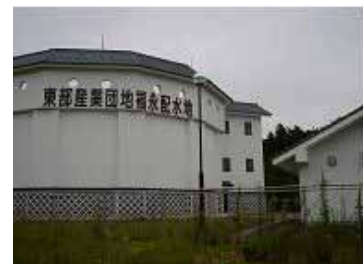
東部産業団地福永配水場
