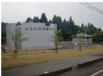
いこいの森配水場
