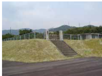
赤坂山配水池
